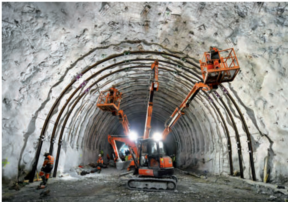
■ Lo scavo in tradizionale a Saint-Martin-La-Porte
