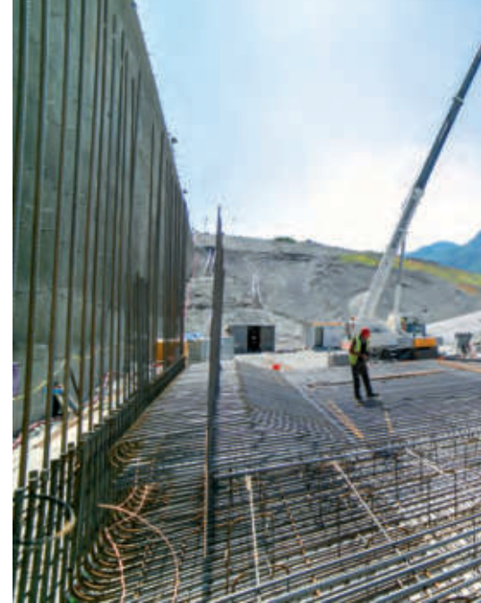
■ I lavori per la tranchée couverte, il portale di accesso al tunnel di base in Francia
