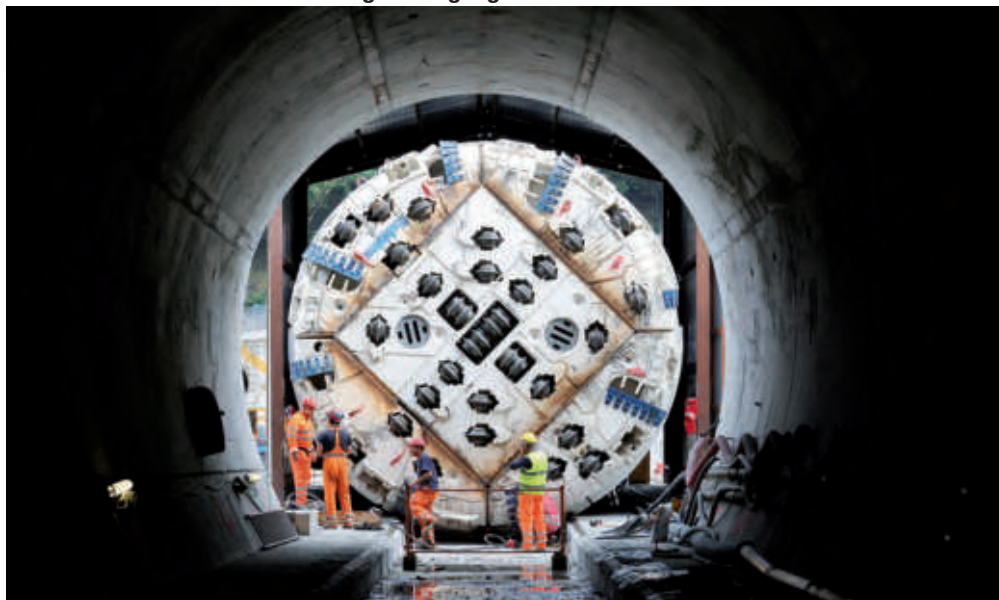
■ La fresa Gea che ha scavato la galleria geognostica di Chiomonte
