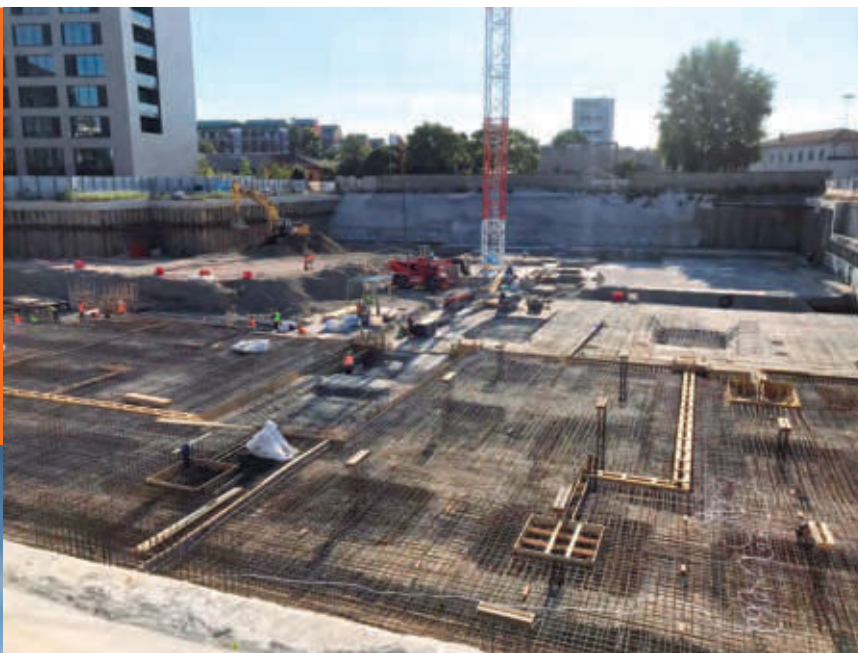
■ Realizzazione della platea di fondazione con il calcestruzzo impermeabile
