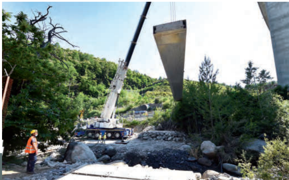
■ Chiomonte, posa del ponte sul torrente Clarea
