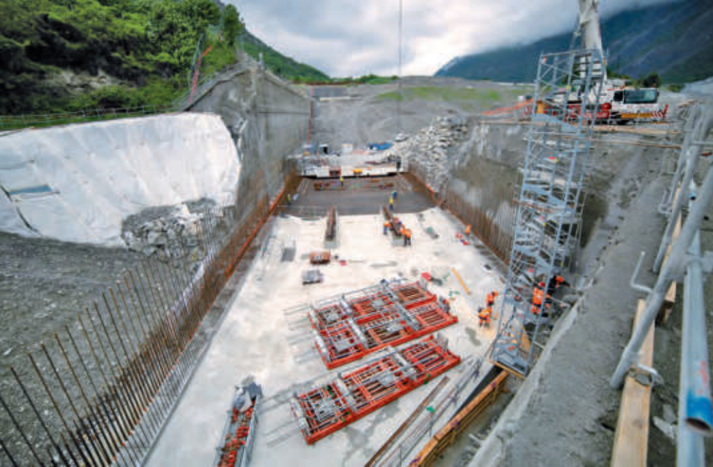
■ I lavori per la tranchée couverte, il portale di accesso al tunnel di base in Francia
